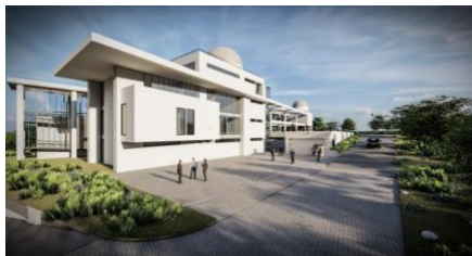
Figura 1. Diseño arquitectónico edificio de investigación - Proyecto Construcción del Centro de Ciencias - Udenar.
