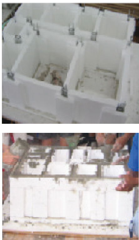
Figura 1. Construção das paredes e colocação da ferragem (em cima); concretagem dos pilares e das vigas (em baixo)
