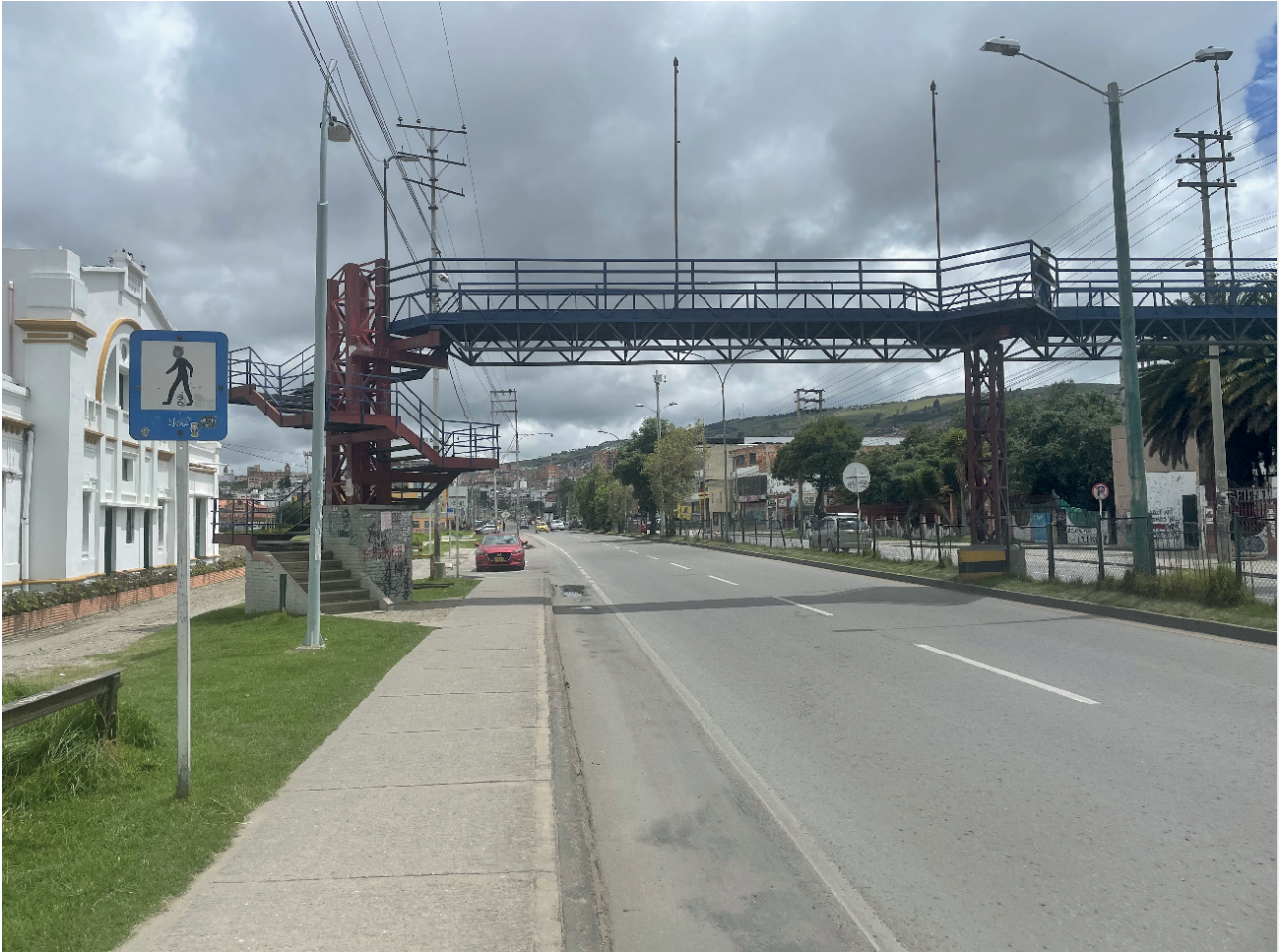
Figura 1. Puente peatonal estudio
