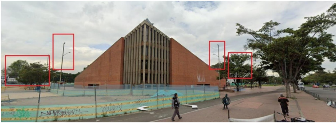
Figura 4. Obstáculos encontrados cerca al coliseo
