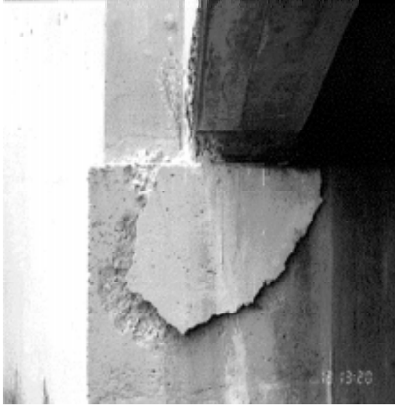
Figura 4. Daño en los Apoyos. Fuente: INVÍAS, Grupo de Puentes
