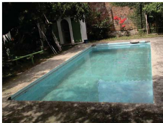
Figura 3. Piscina de 50m 3
