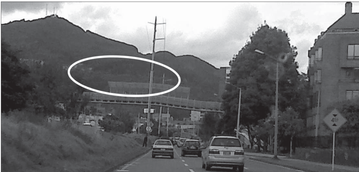
Figura 6. Puente peatonal con exposición al efecto arco de una línea de energía eléctrica de alta tensión. Carrera novena, Bogotá D.C. 2011
