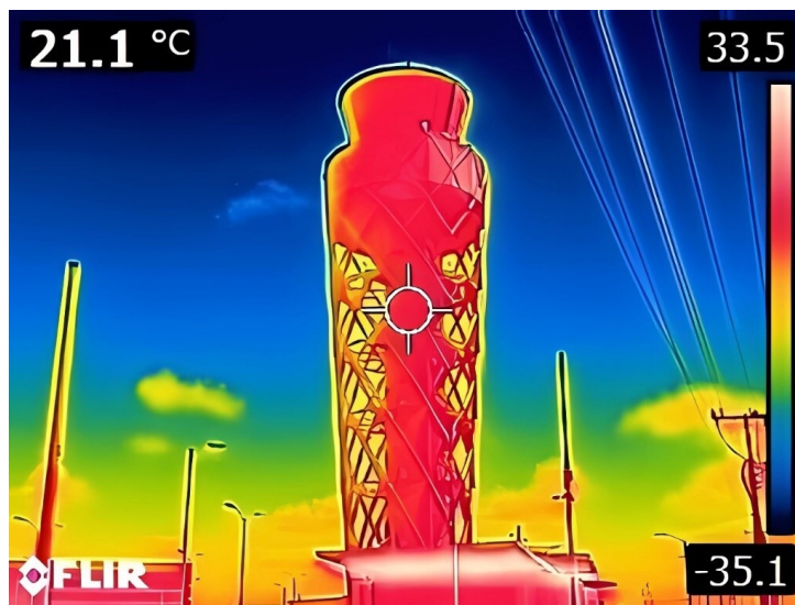
Figura 1. Termograma torre de control Aeropuerto el Dorado Bogotá
