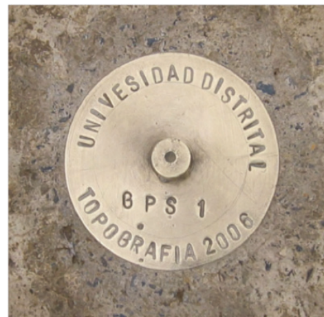
Figura 4. Vértice geodésico materializado
