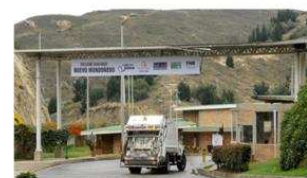
Figura 1. Entrada relleno sanitario Nuevo Mondoñedo. (CORATIERRAS, 2018)
