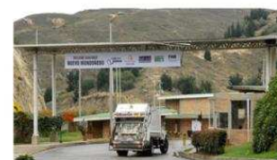
Figura 1. Entrada relleno sanitario Nuevo Mondoñedo. (CORATIERRAS, 2018)
