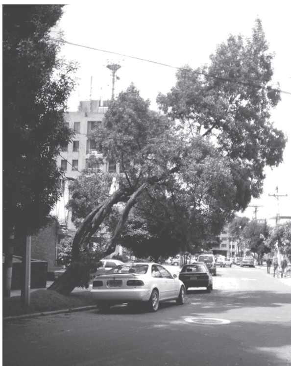
Figura 1. Árbol inclinado con riesgo alto e inminente de volcamiento
