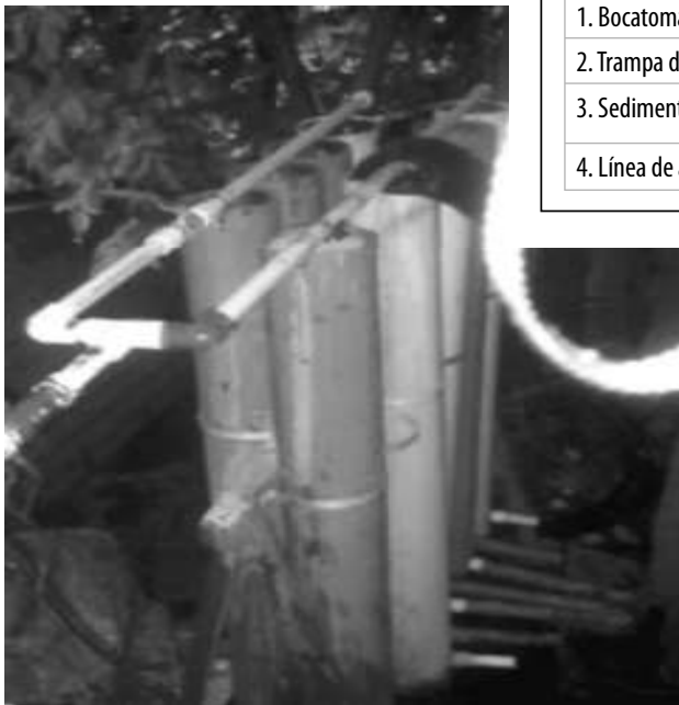
Instalación del prototipo en la quebrada.
