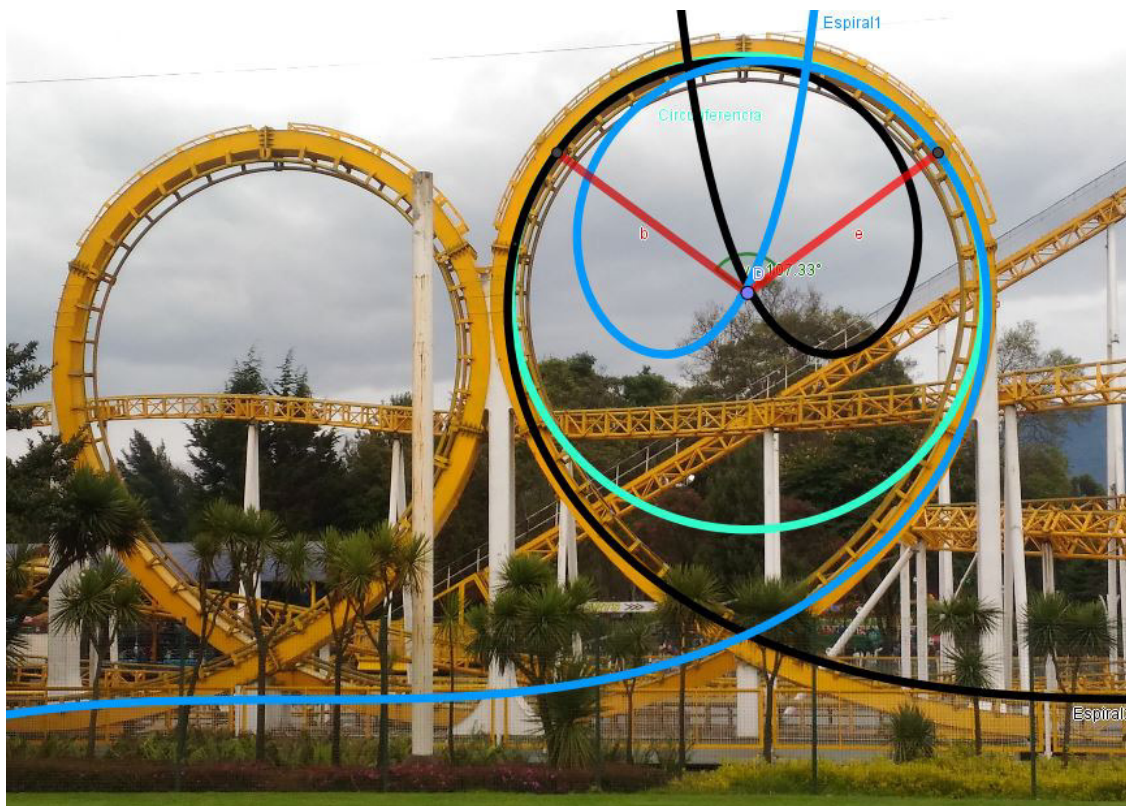
Figura 13: Montaña rusa Doble loop del parque Salitre Mágico. En esta imagen se evidencia la secuencia espiral de Euler-circunferencia-espiral de Euler que se aproxima a uno de los bucles de esta atracción mecánica. Las curvas azul y negra son dos espirales de Euler y la verde a un arco circunferencia.
