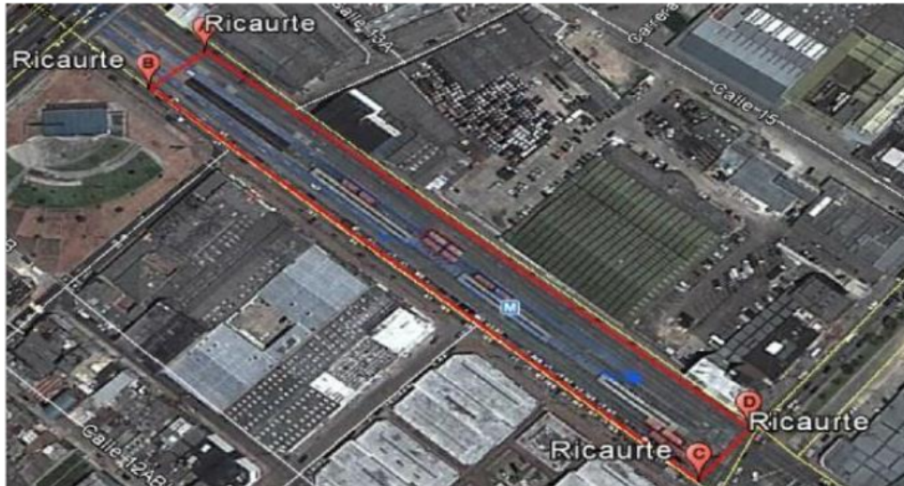
Figura 2. Imagen estación Ricaurte, área para encerrar estación punto A, B, C, D. Fuente: captura imagen del software Google Earth Región Bogotá – Colombia
