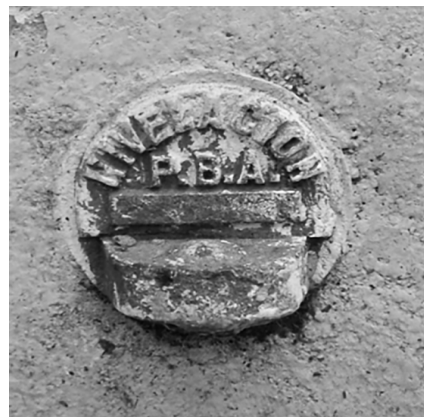
Figura 3. Punto fijo ubicado en la cara sudeste del edificio de Química.
