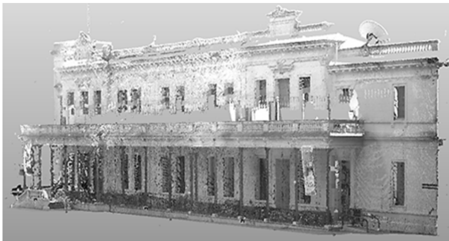
Figura 18. Nube de puntos 3D georreferenciada y texturizada de la fachada de rumbo sudoeste del edificio central de la Facultad de Ingeniería.
