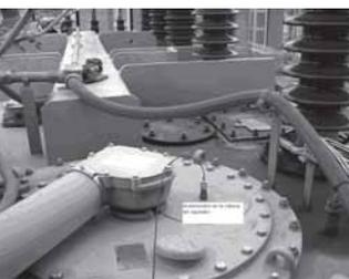
Figura 11. Acelerómetro encima de la cabeza del regulador
