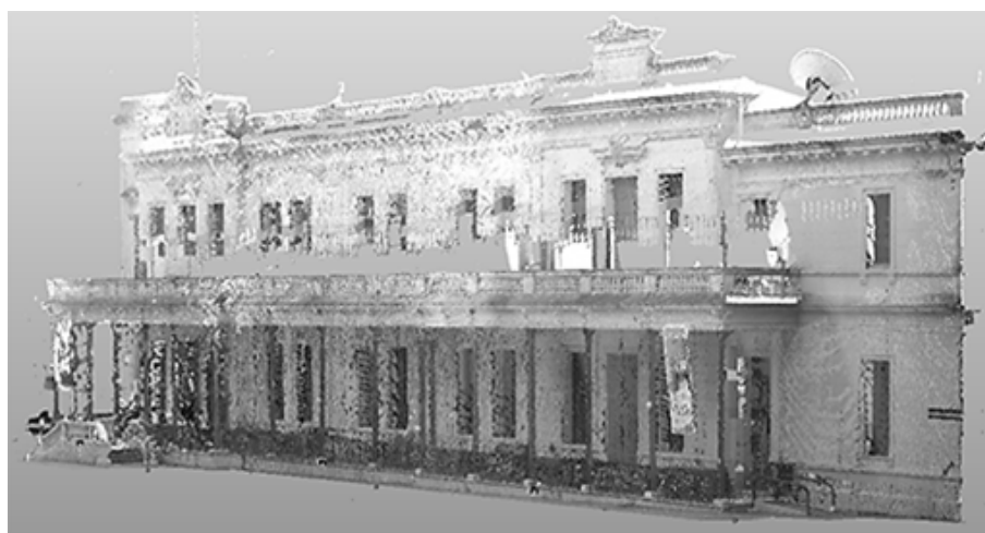
Figura 18. Nube de puntos 3D georreferenciada y texturizada de la fachada de rumbo sudoeste del edificio central de la Facultad de Ingeniería.
