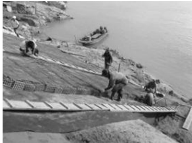
Figura 15. Colocación de Geoestructuras
