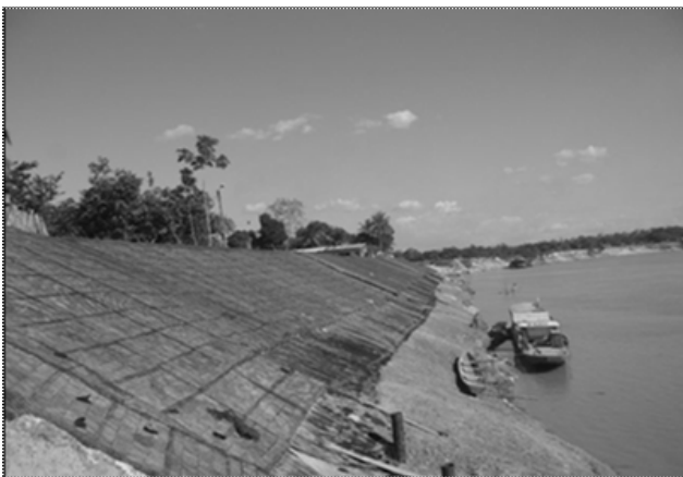
Figura 14. Taludes recubiertos con geoestructuras
