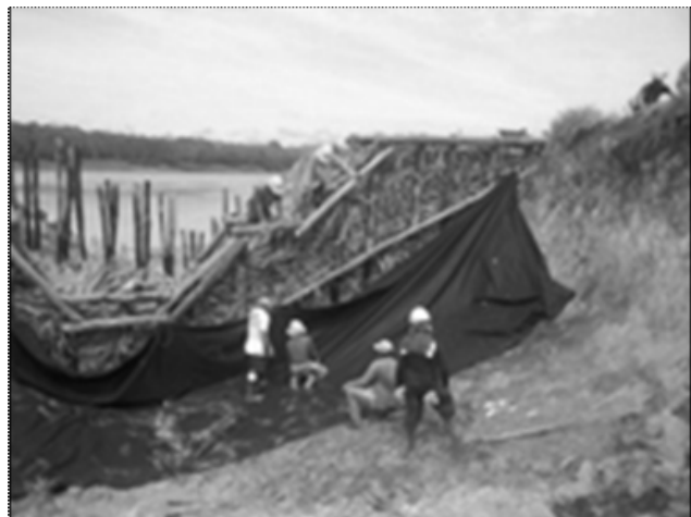
Figura 17. Conformación de Trinchos Fuente: Autor
