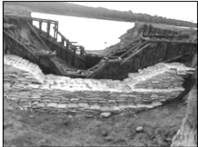
Figura 16. Trinchos construidos
