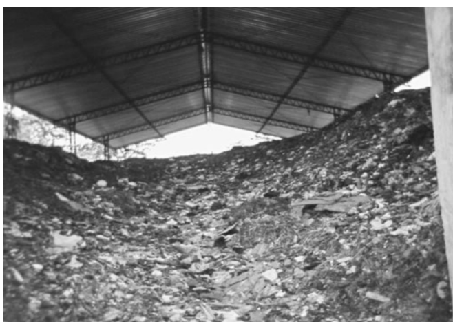
Figura 2. Celda de acopio de los residuos del municipio. Fuente: Cárdenas Y., 2006
