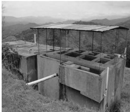
**Figuras 6 y 7.** Estructuras del tratamiento y almacenamiento del agua en Viotá.
