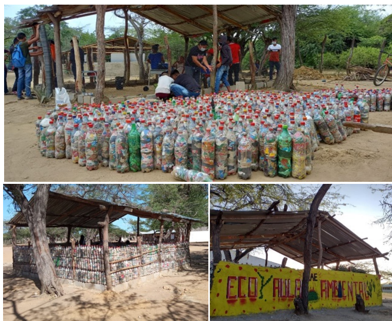
(Imagen 4) Proceso de construcción de la Eco Aula ambiental
