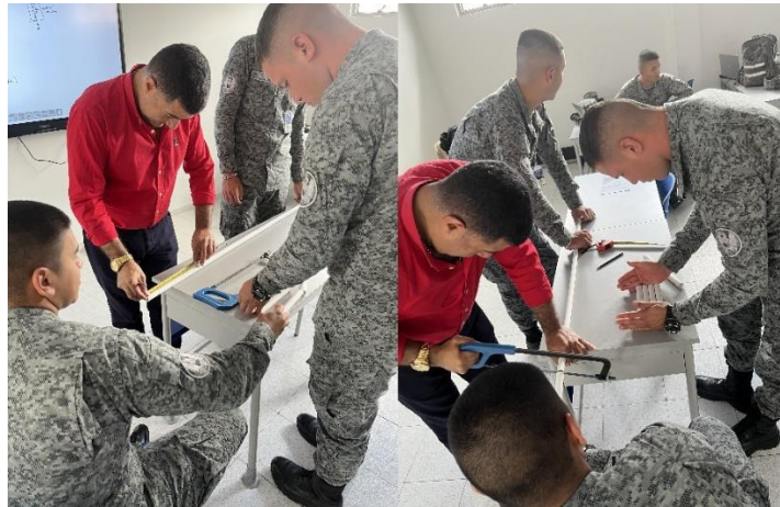
Figura 13. Cortes de las diferentes piezas de PVC.
