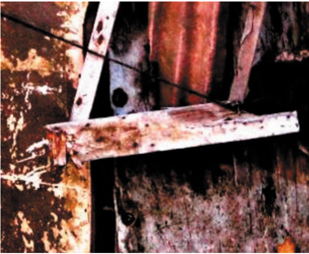
Fachada de mi vecino, Asentamiento Humano Hijos de Grau. Ventanilla- Callao. 2004
