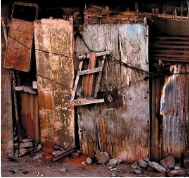
Fachada de mi vecino, Asentamiento Humano Hijos de Grau. Ventanilla- Callao. 2004
